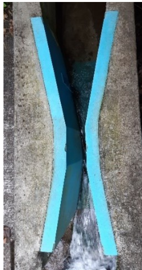
Ilustración 11: Canaleta Parshall - entrada al desarenador convencional. Fuente: Elaboración Propia.
