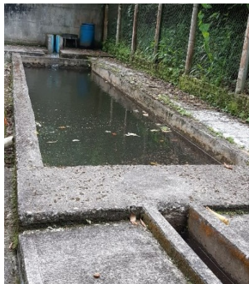
Ilustración 10: Desarenador convencional. Fuente: Elaboración Propia.
