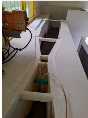
Ilustración 30: Componentes Mezcla Rápida PTAP Convencional Mistrató. Fuente: Elaboración propia.
