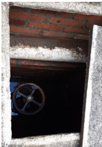
Ilustración 12: Caja de lavado desarenador convencional. Fuente: Elaboración Propia.
