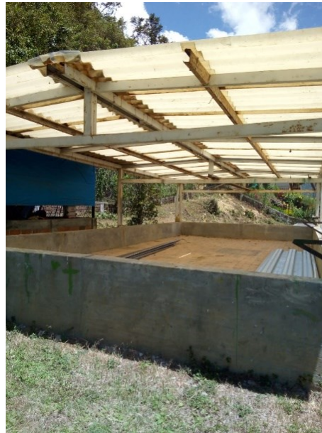
Ilustración 41: Lechos de Secado de Lodos PTAP Mistrató. Fuente: Elaboración propia.
