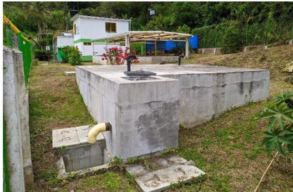
Ilustración 38: Tanque de Contacto de Cloro PTAP Mistrató. Fuente: Elaboración propia.
