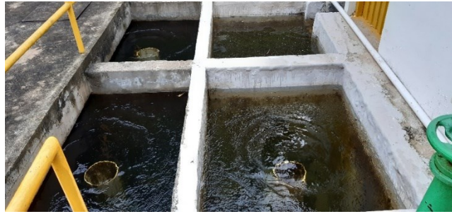
Ilustración 32: Floculadores tipo Alabama PTAP Mistrató – Risaralda. Fuente: Elaboración propia.
