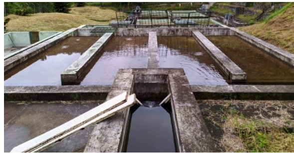
Ilustración 15: Vertedero triangular – entrada a la FIME. Fuente: Elaboración Propia.
