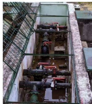
Ilustración 19: Válvulas de Apertura y Cierre Rápido. Fuente: Elaboración Propia.
