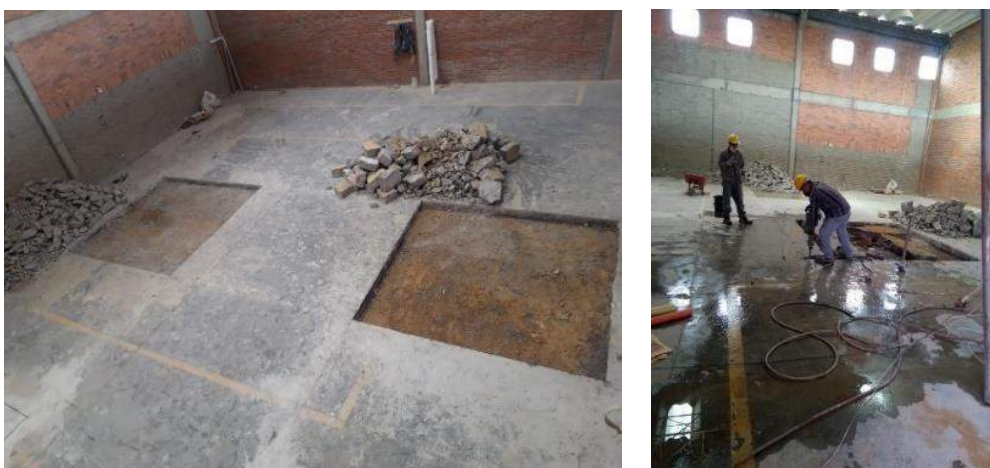
Figura 21 Evidencia fotográfica de actividades de obra
