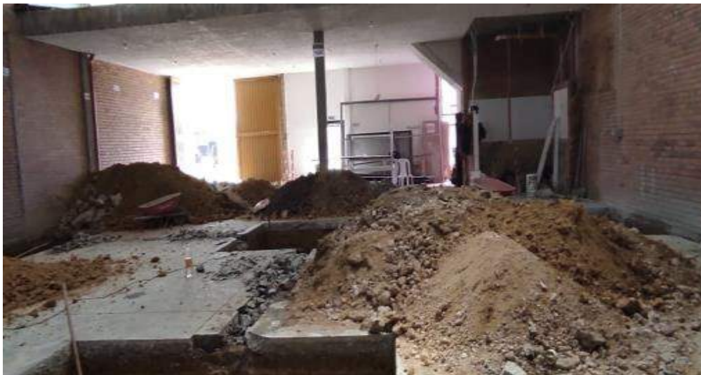
Figura 22 Excavación manual en material común
