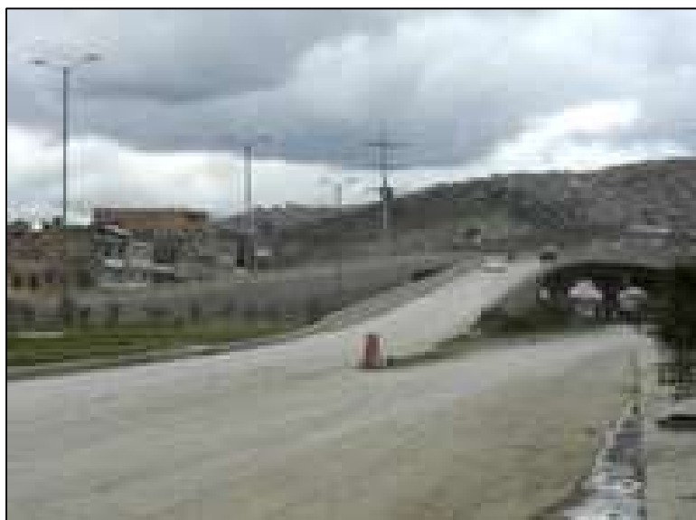
Figura 14 Imagen Puente Vehicular de Terreros Fuente: ( periodismopublico.com, 2013, pág. 1 )
