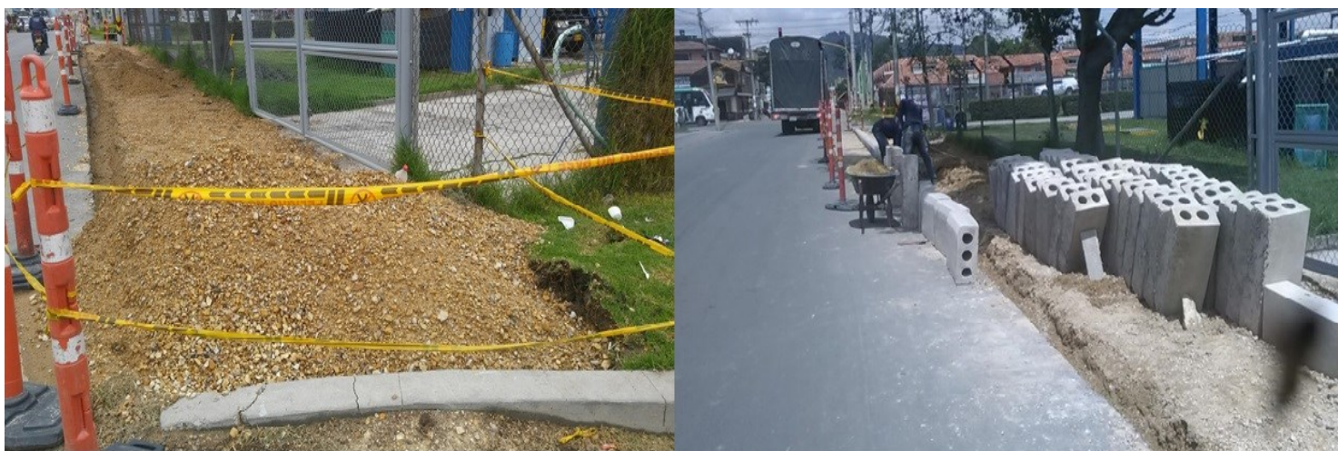
Ilustración 32: Durante la intervención tramo 1 norte.
