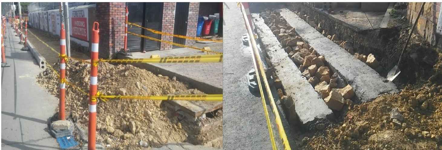
Ilustración 35: Durante la intervención tramo 1 sur
