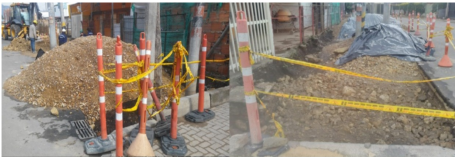
Ilustración 38: Durante la intervención tramo 2 norte.
