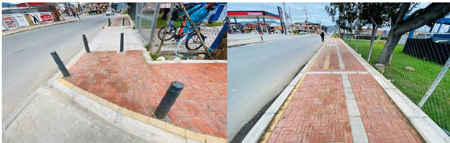
Ilustración 33: Después de la intervención tramo 1 norte.
