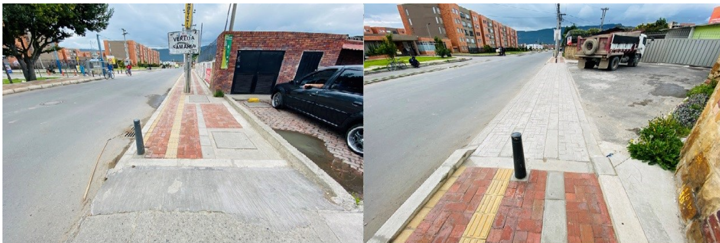
Ilustración 36: Después de la intervención tramo 1 sur.
