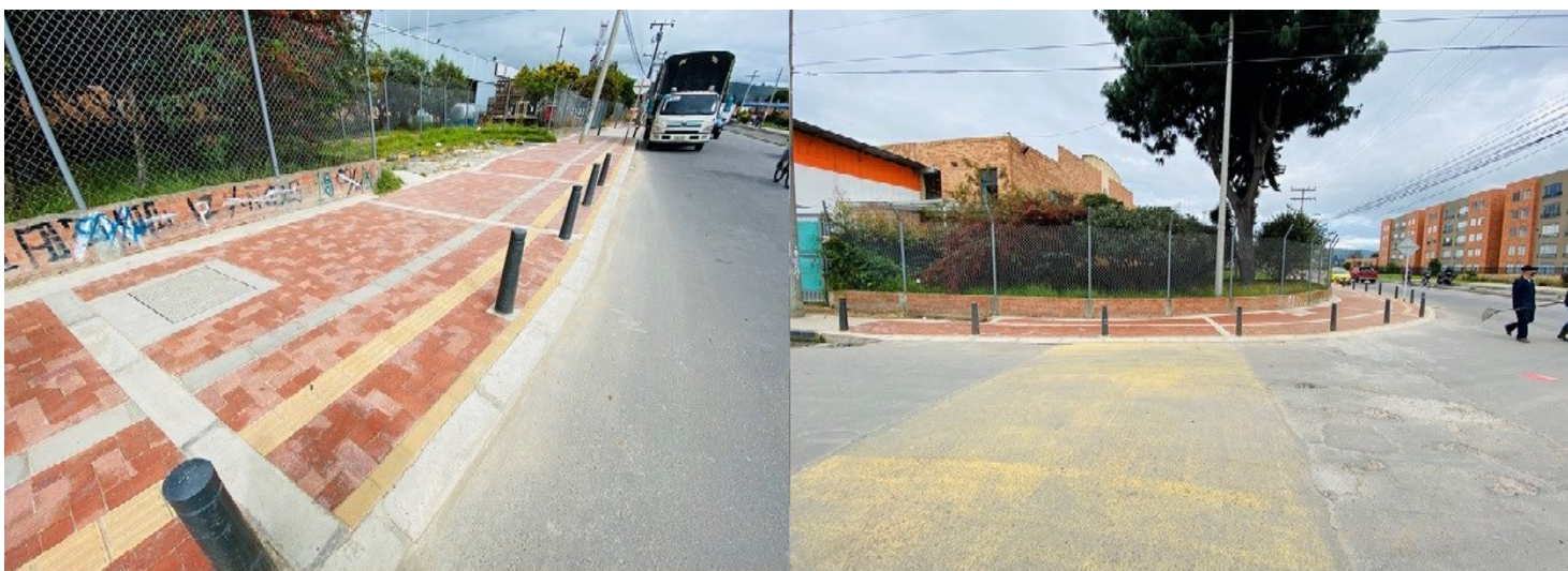
Ilustración 42: Después de la intervención tramo 2 sur.
