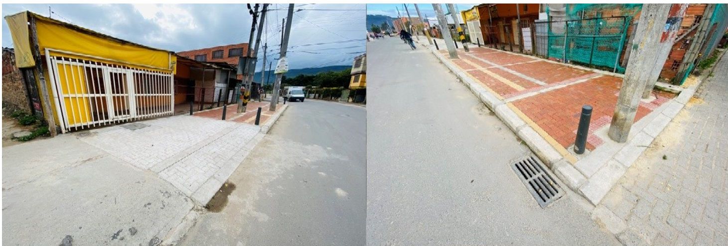
Ilustración 39: Después de la intervención tramo 2 norte.
