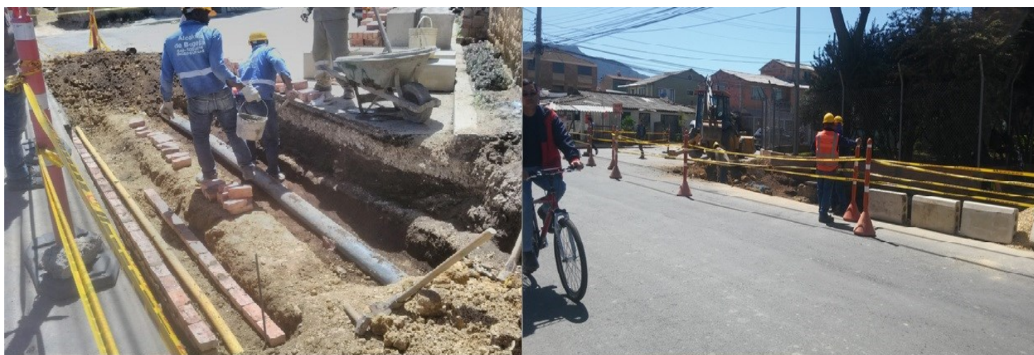
Ilustración 41: Durante la intervención tramo 2 sur
