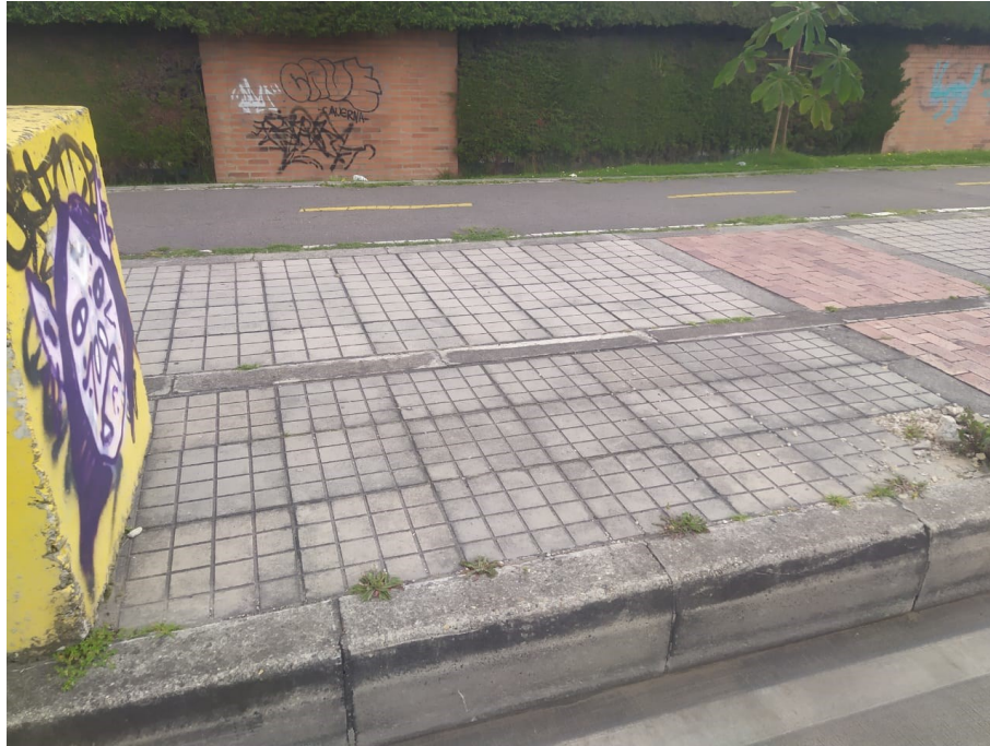
REGISTRO FOTOGRAFICO 2 CRA 80 CON CALLE 42A SUR
