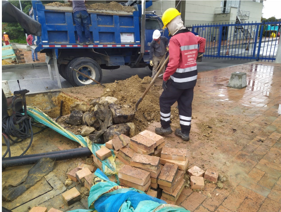
REGISTRO FOTOGRAFICO 10 CALLE 35B SUR CON TRANSVERSAL 72N
