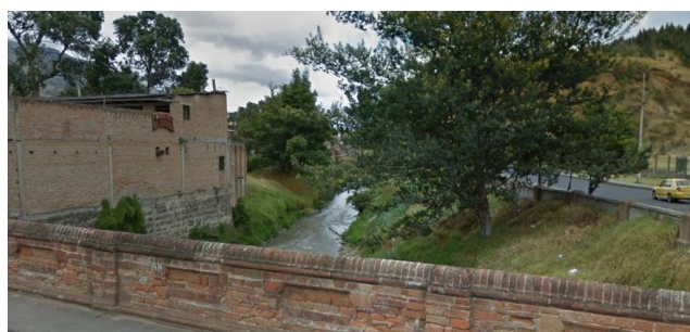
Ilustración 30. Puente Cra 12 Río Pasto Fuente: Propia
