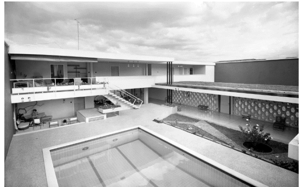
Ilustración 35. Casa Ambrosina de Borrero, Arquitectos Borrero, Zamorano y Giovanelli Santiago de Cali, Valle del Cauca 1953
