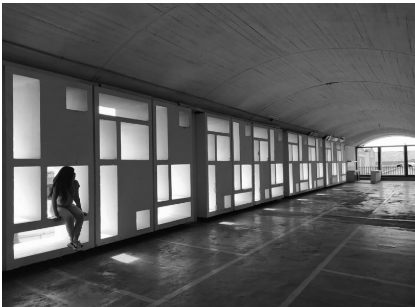
Ilustración 5. Ventanas Fachada Oeste Galería Central Fuente: Propia
