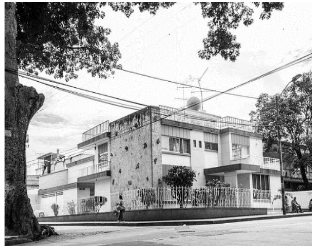
Ilustración 69. Casa Torres Calle 1 # 13-64 1970-1980
