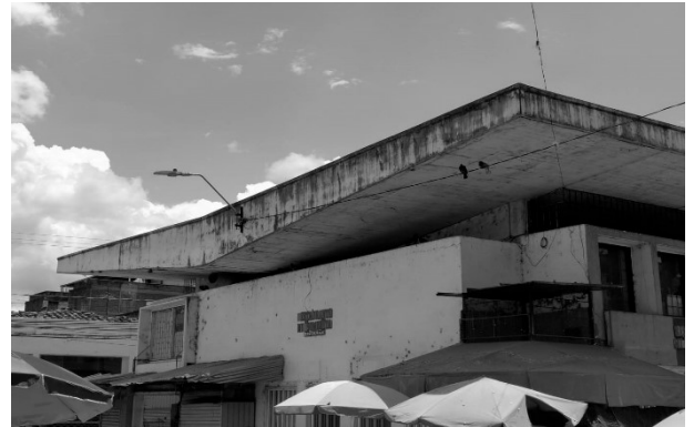
Ilustración 142. Cubierta Mariposa Isla Comercial Fuente: Propia
