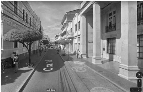
Ilustración 104. Recorrido por la Carrera 13 Sentido Norte-Sur Alcaldía Municipal Fuente: Google Imágenes
