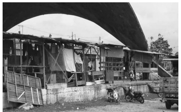
Ilustración 128. Galería Satélite Abandono Fuente: Propia
