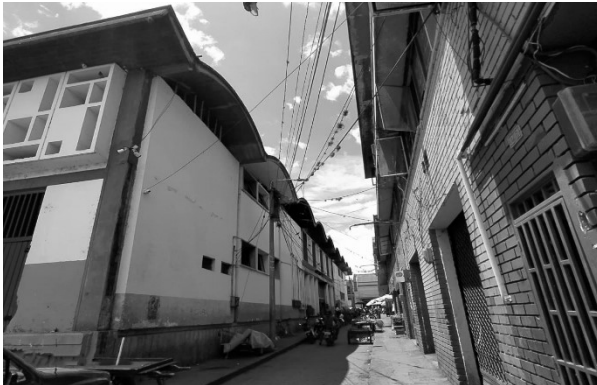
Ilustración 143. Bóvedas Galería Central Fuente: Propia
