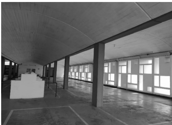
Ilustración 141. Fachada Oeste Interior Galería Central Fuente: Propia
