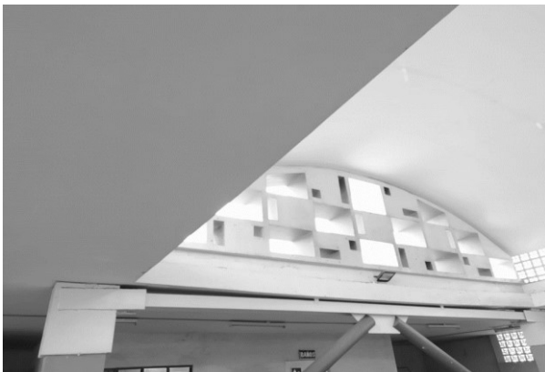
Ilustración 2. Bóveda Pabellón de Carnes Fuente: Propia
