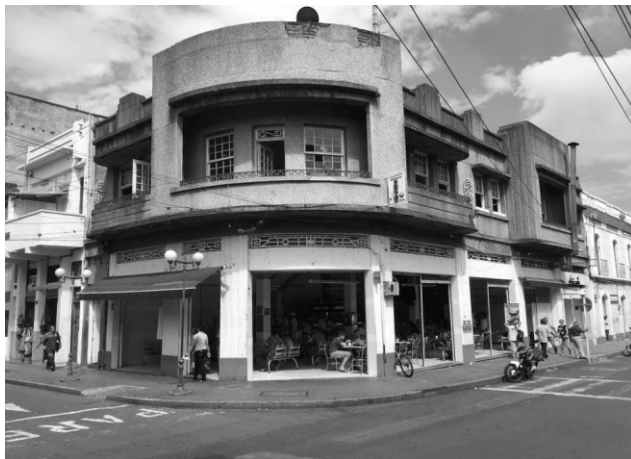
Ilustración 12. Café Canaima Edificación Art Deco Fuente: Propia
