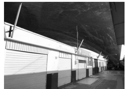
Ilustración 3. Cubierta Galería Satélite Fuente: Propia
