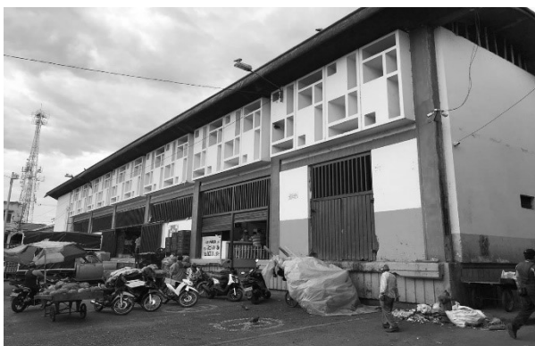
Ilustración 129. Galería Central Basuras Fuente: Propia
