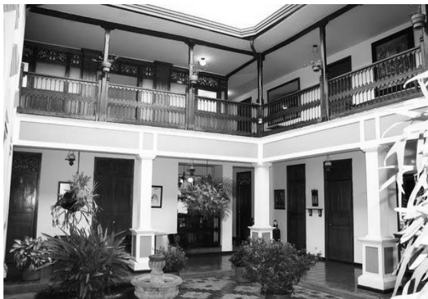
Ilustración 9. Interior Edificio Portales de Fuenmayor Edificación Republicana Fuente: Propia
