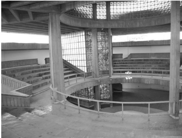
Ilustración 166. Iglesia del Seminario Los Doce Apóstoles Antes Reforma 2015 Fuente: Mauricio González Arroyave
