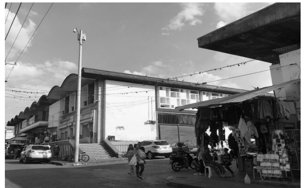
Ilustración 134. Galería Central Afectación Espacio Público Fuente: Propia
