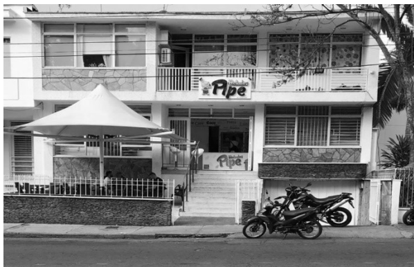
Ilustración 135. Vivienda Calle 1 Incurción Comercial Fuente: Propia
