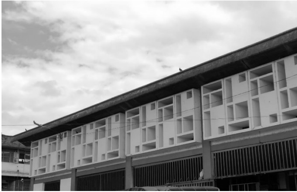
Ilustración 145. Calados Fachada Oeste Galería Central Fuente: Propia
