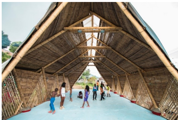
Imagen 6. Fotografía Interior de la Casa Ensamble Chacarrá en Pereira.
