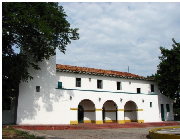
Imagen 18: Estación De Ferrocarril-Neiva
