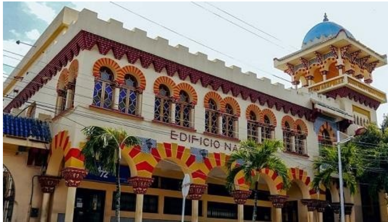
Figura 72 Edificio Nacional Neiva Urbana
