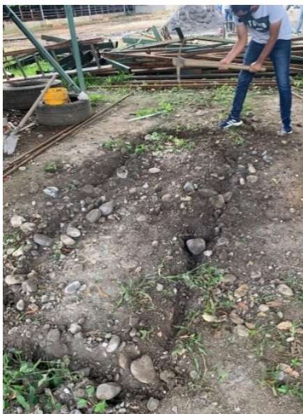
Ilustración 4. Demarcación de la zanja.
