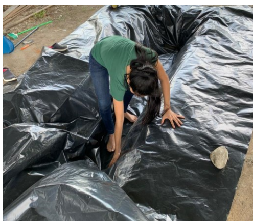
Ilustración 15. Recubrimiento de la zanja.
