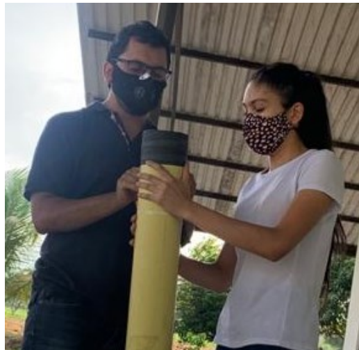
Ilustración 12. Forrado de tubería.
