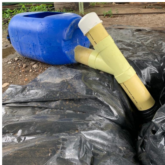
Ilustración 17. Conexión de caja de entrada en el prototipo del biodigestor tubular
