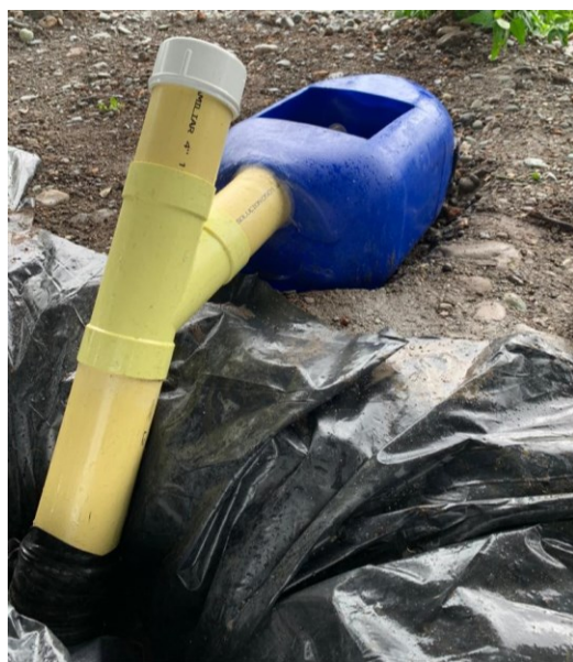
Ilustración 18. Conexión de caja de salida con el prototipo del biodigestor tubular
