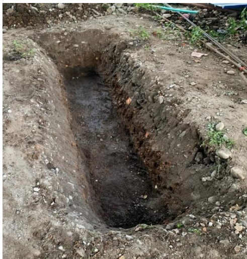
Ilustración 5. Excavación de la zanja.
