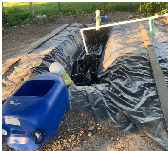
Ilustración 20. Prototipo del biodigestor tubular
