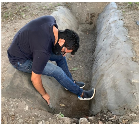
Ilustración 7. Acondicionamiento de paredes laterales.
