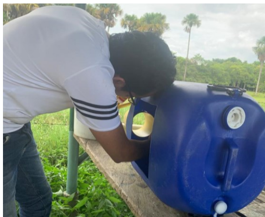
Ilustración 14. Caja de salida del prototipo del biodigestor tubular
