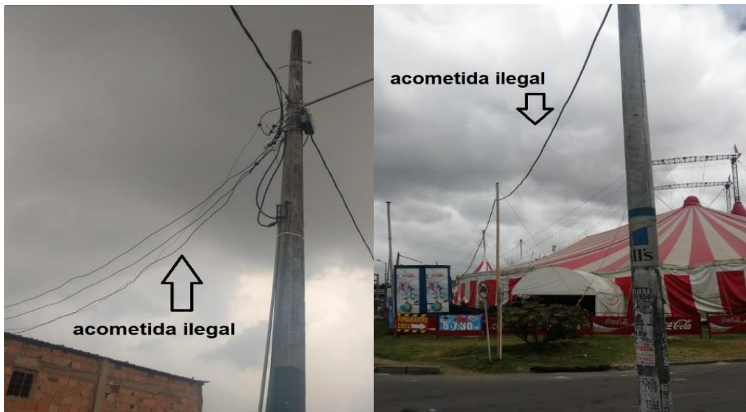
Figura 1-5. Conexiones ilegales o directas
