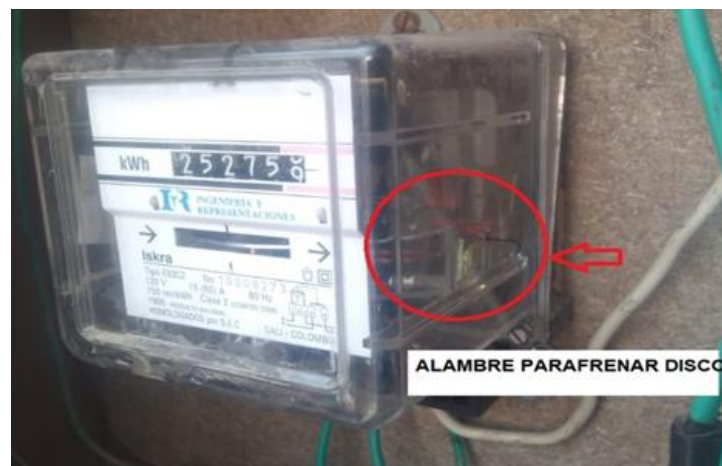
Figura 1-3. Perforaciones en la tapa principal del medidor
