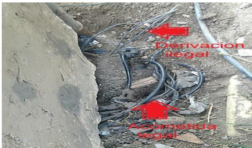
Figura 1-6. Perforación de acometidas o bypass
