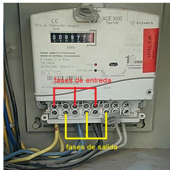
Figura 1-7. Alteración de la secuencia de fases
