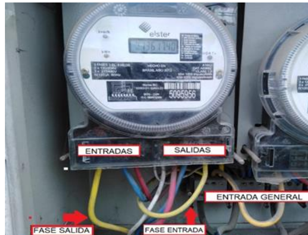
Figura 1-2. Cambio fase invertida en las entradas del medidor
