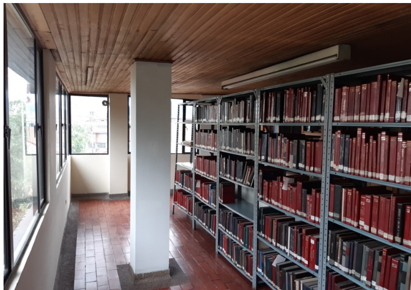
Figura 3-24: Piso 4 área interna
