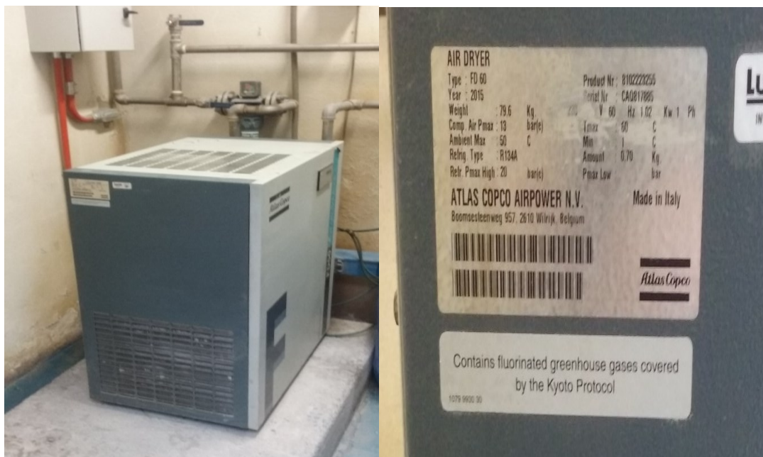
Figura 8. Secador Frigorífico FD60 Atlas Copco Área Zootecnia Sólidos
