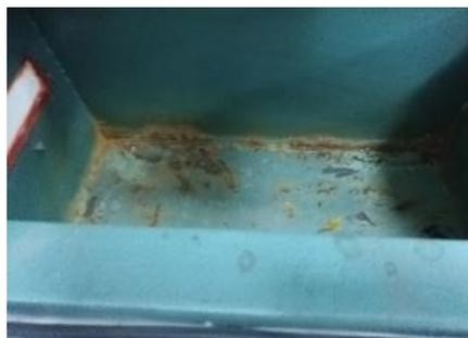
Ilustración 15. Estado inicial de los depósitos de agua
