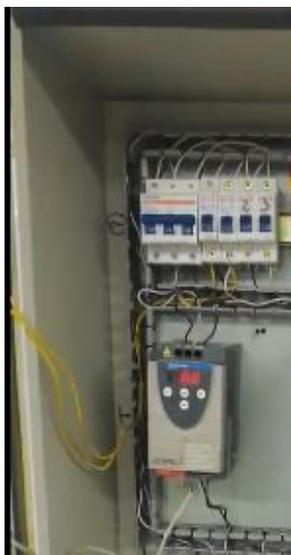
Ilustración 9. Prueba de funcionamiento de variador
