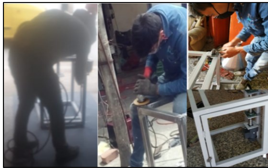
Figura 4-10 Desarrollo, construcción de la estructura y ruedas
