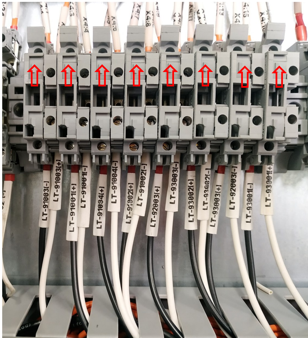
Figura 3-38 Conexión de señales de los instrumentos
