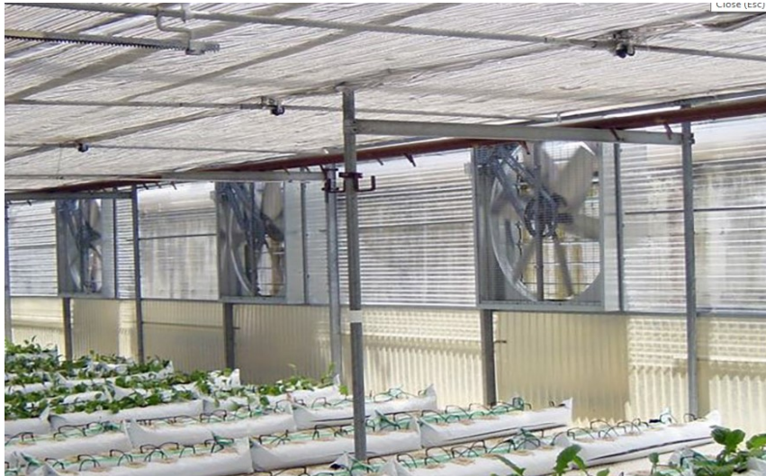
Figura 2-2: Instalación de extractores sobre la parte lateral del invernadero.
