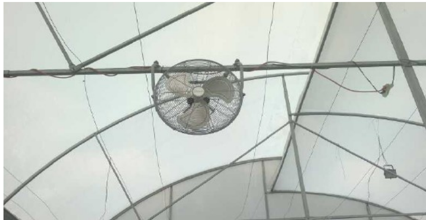
Figura 2-3: Instalación de ventilador en la superior del invernadero.
