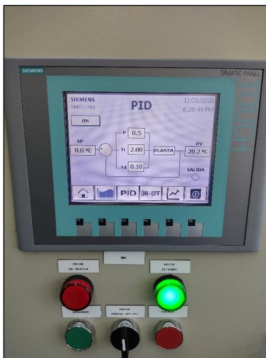
12. Para apagar los controles dejar el selector de tres posiciones en modo off, (posición central) y esperar que la temperatura de los tanques retorne a la del ambiente.
