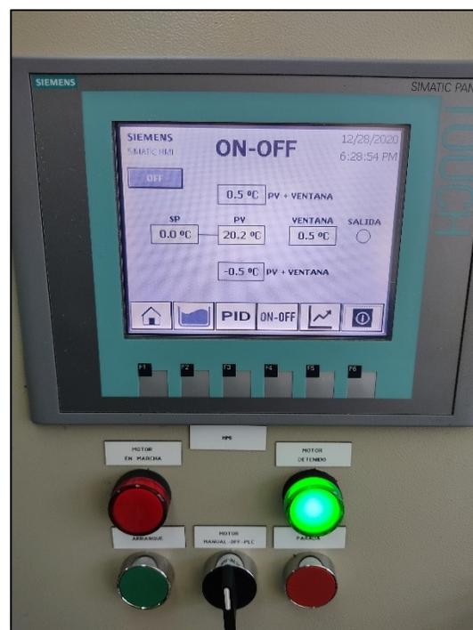
10. Establecer el valor de la temperatura deseada de la planta en el ícono SP por medio del teclado numérico de la pantalla. Si se desea cambiar el valor de la ventana o rango +/- de temperatura, oprimir suavemente cualquiera de los iconos “ventana” y agregar el valor deseado. Cuando la resistencia esté activa, el ícono circulara “salida” se pondrá en color blanco.
