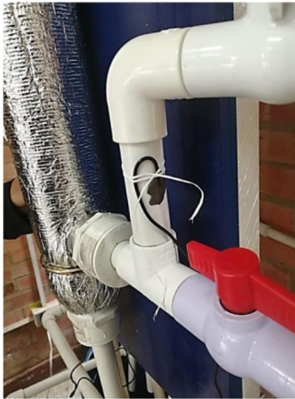
Figura 35. Adaptación de sensores y sellado con masilla.
