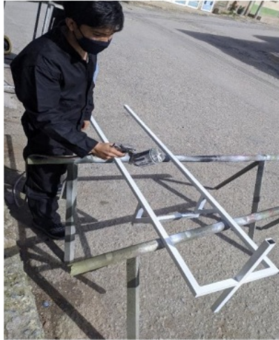
Figura 30. Aplicación de recubrimiento de pintura estructura metálica.
