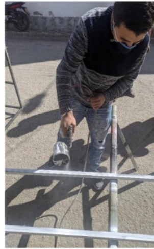
Figura 30. Aplicación de recubrimiento de pintura estructura metálica.
