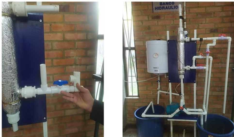
Figura 34. Adaptación en el laboratorio y ensamble de accesorios y tubería
