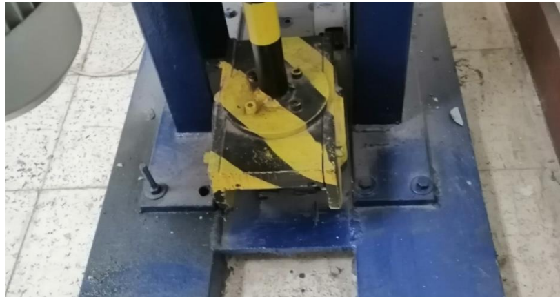
Figura 2-2: Estado de la base.
