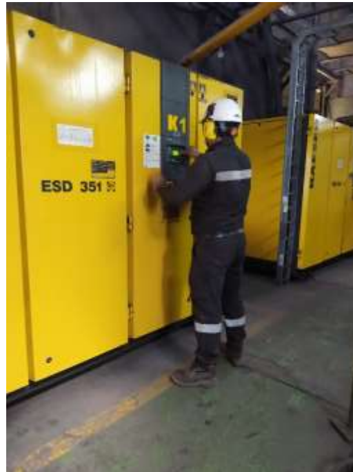
Figura 5: Toma de datos de consumo eléctrico de compresores con diferentes variables en parámetros de carga-vacío.
