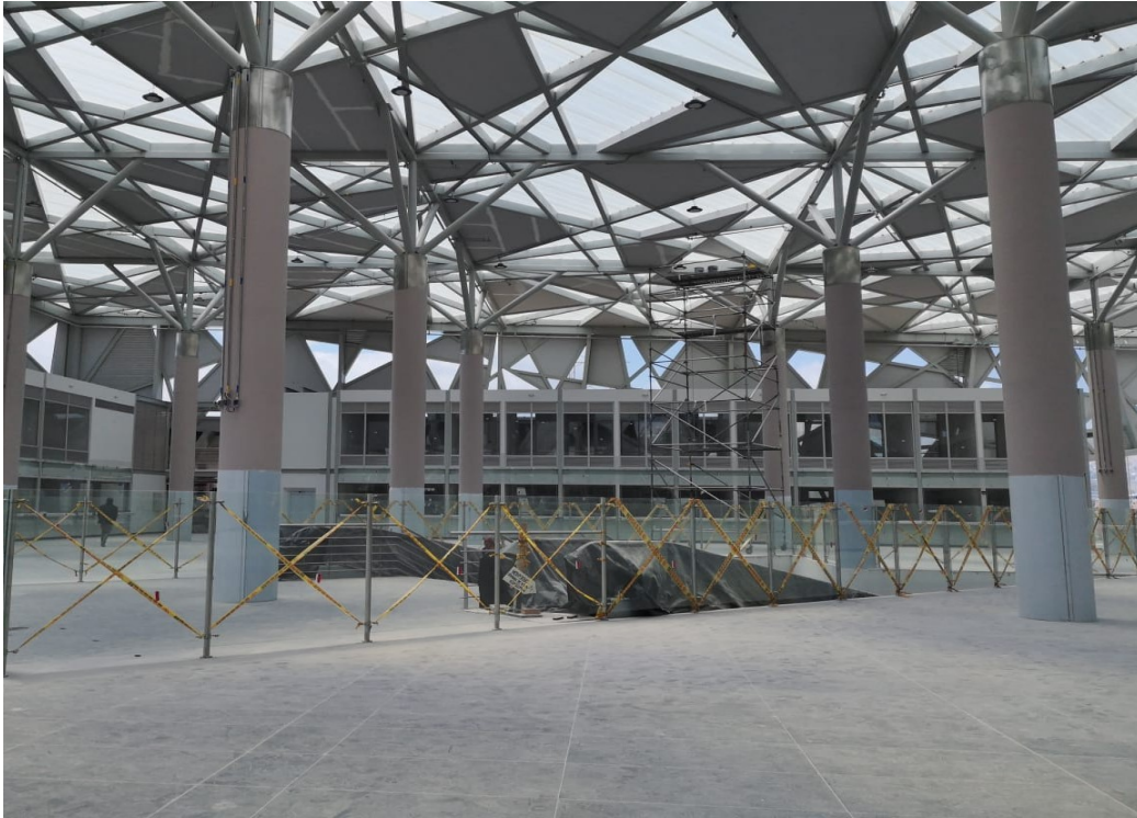
Figura 1-2 Iluminación cenital. Terminal de Transporte Tunja (Boyacá)
