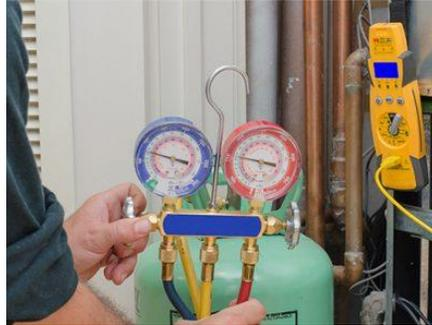
Figura 31. Medición de presiones de línea de alta y de baja en un compresor.
