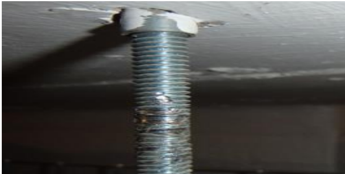
Figura 2-8: Barras roscadas usadas como soporte.
