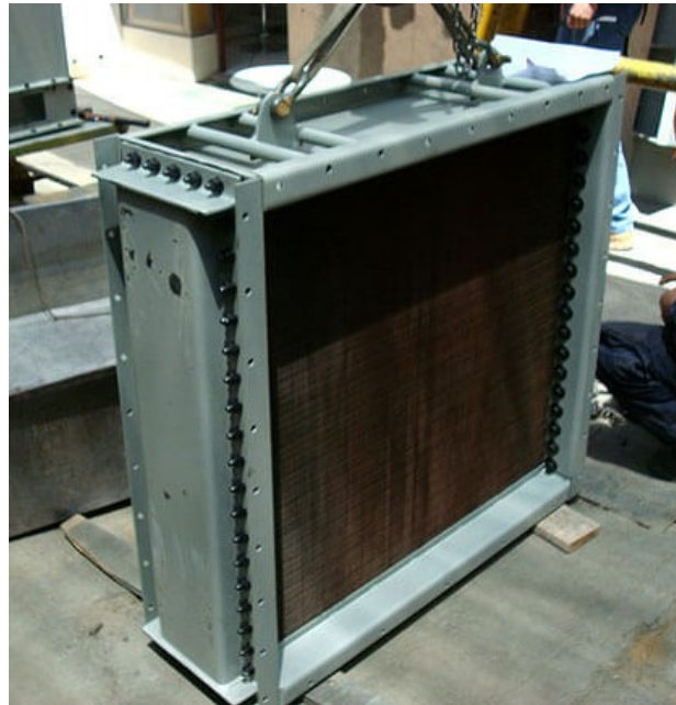
Figura 3.4 Intercambiador de calor de tipo compacto
