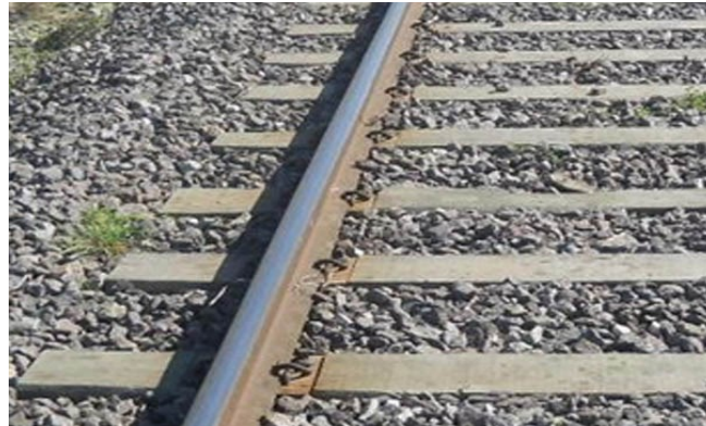
Figura 1-22: Durmiente en madera y rieles metálicos.
