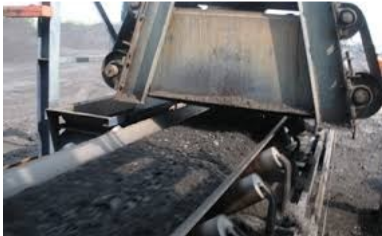
Figura 1-12: Sistema de banda transportadora.
