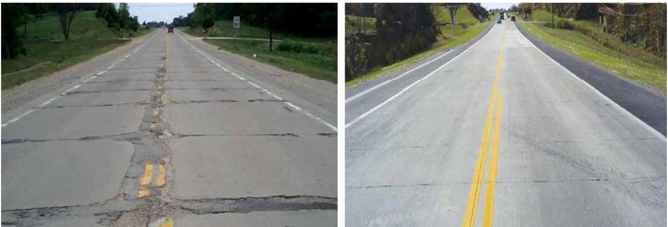
Nota: La figura muestra la aplicación de la técnica Whitetopping en una vía que se encontraba en mal estado. Fuente: Tomado de (CPTechCenter, 2015)
