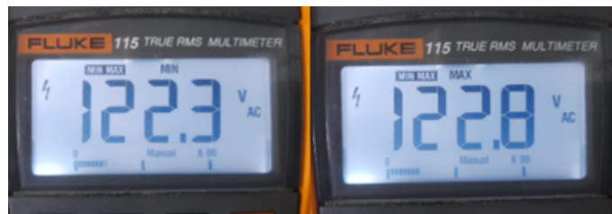
Figura 4-15.: Voltaje medido a través de instrumento Fluke
