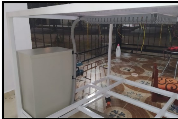
Ilustración 45: Ubicación de las bases adhesivas para el fijado de la coraza liquid tight con amarres plásticos
