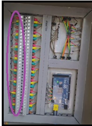
Ilustración 40: Ubicación e instalación del cable de control en el tablero de circuitos
