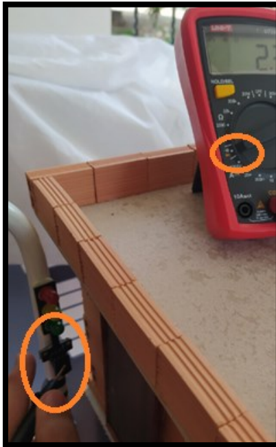
Ilustración 104: Revisión del parámetro continuidad desde las bornas hasta los pines de los módulos de semaforización.
