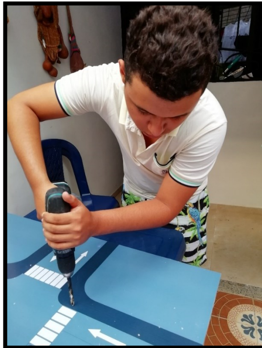
Ilustración 27: Elaboración de perforaciones para la creación de los huecos donde encajarán los tubos de cobre que serán usados para los semáforos
