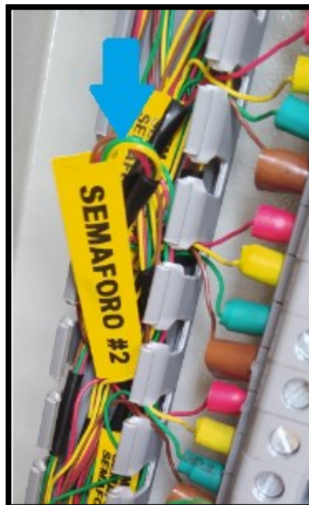
Ilustración 91: Revisión en los cables (dobles) en busca de posibles anomalías o puntos calientes.
