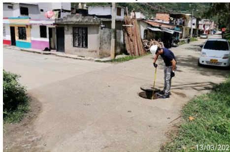
Figura 19. Inspección pozo N° 19.
