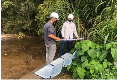
Figura 14. Verificación planimétrica del sistema de alcantarillado.
