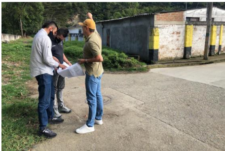
Figura 16. Recorrido e inspección visual del trazado de los colectores evaluados.
