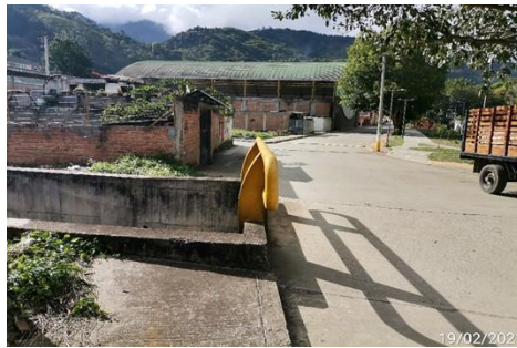
Figura 17. Canal abierto de quebrada Arrayanes
