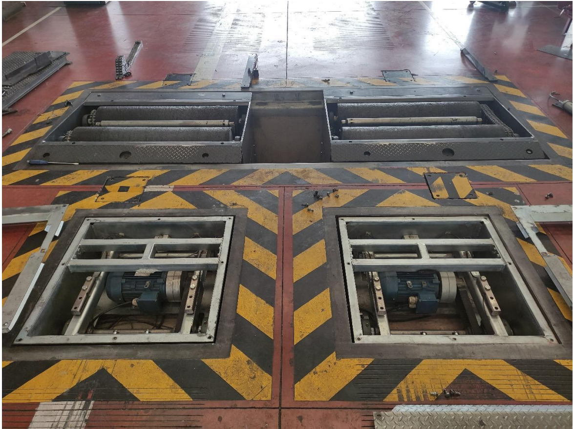
Figura 20-3 Mantenimiento Zona C
