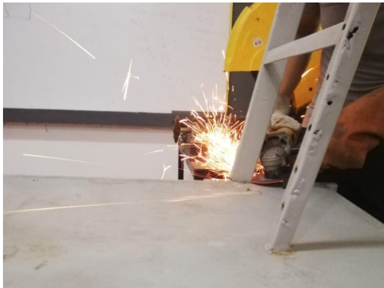
Figura 9-39: Remoción del tablero antiguo.
