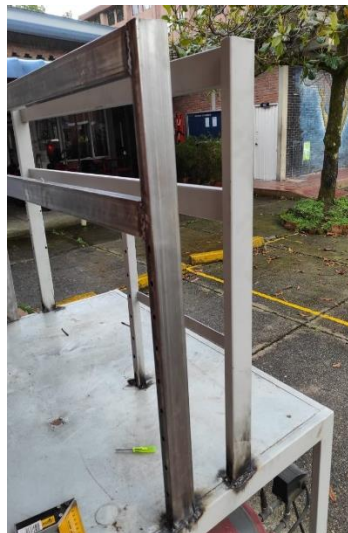
Figura 9-41: Proceso de soldadura de los tableros.
