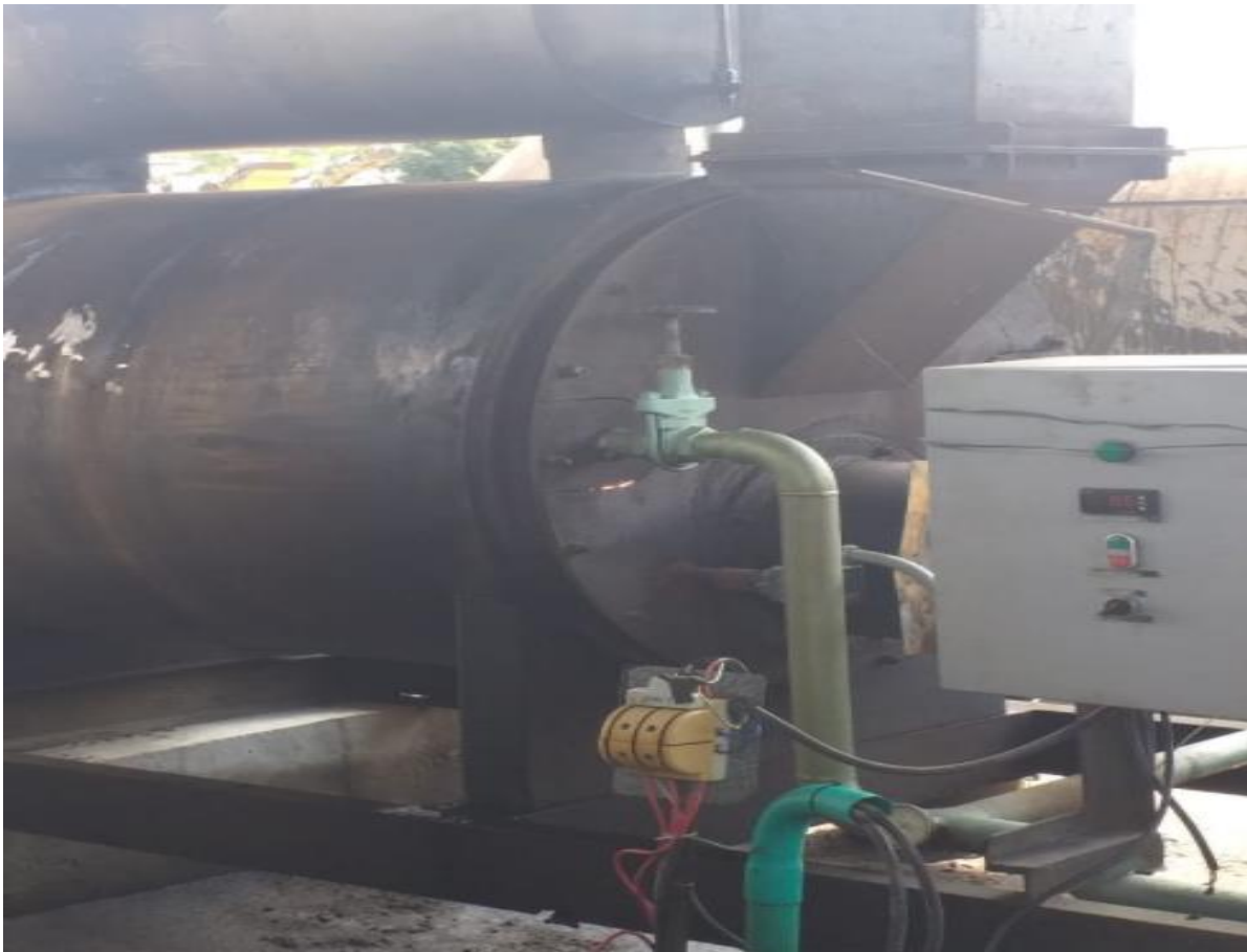
Figura 11 Sistema de calentamiento del cemento asfáltico
