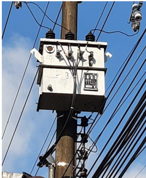
Figura 12. Transformador de 30 KVA y Diagrama unifilar
