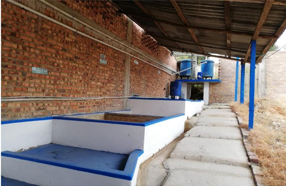
Figura 16 Fotografía suministrada por la empresa Incolcueros López. Caudal de entradas de agua a través de alcantarillas, Cámara de recibimiento y Cámara de arena.
