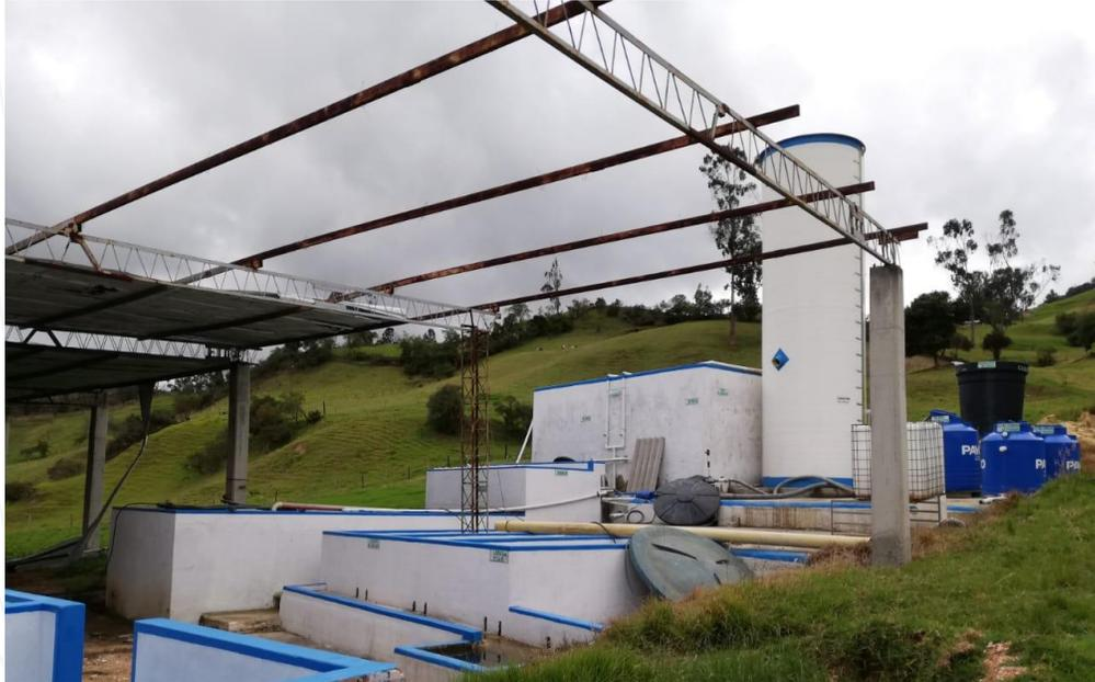
Figura 14 Fotografía suministrada por la empresa Incolcueros López. Planta de Tratamiento de Aguas Residuales, Tanque primario de sedimentación, Tanque de estabilización, Bombas de retorno, tanques finales de sedimentación y conducto de descarga
