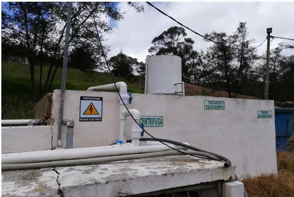
Figura 15 Fotografía suministrada por la empresa Incolcueros López. Tanque de Centrifugado, Tratamiento Físico-químico y Tanque de oxidación.
