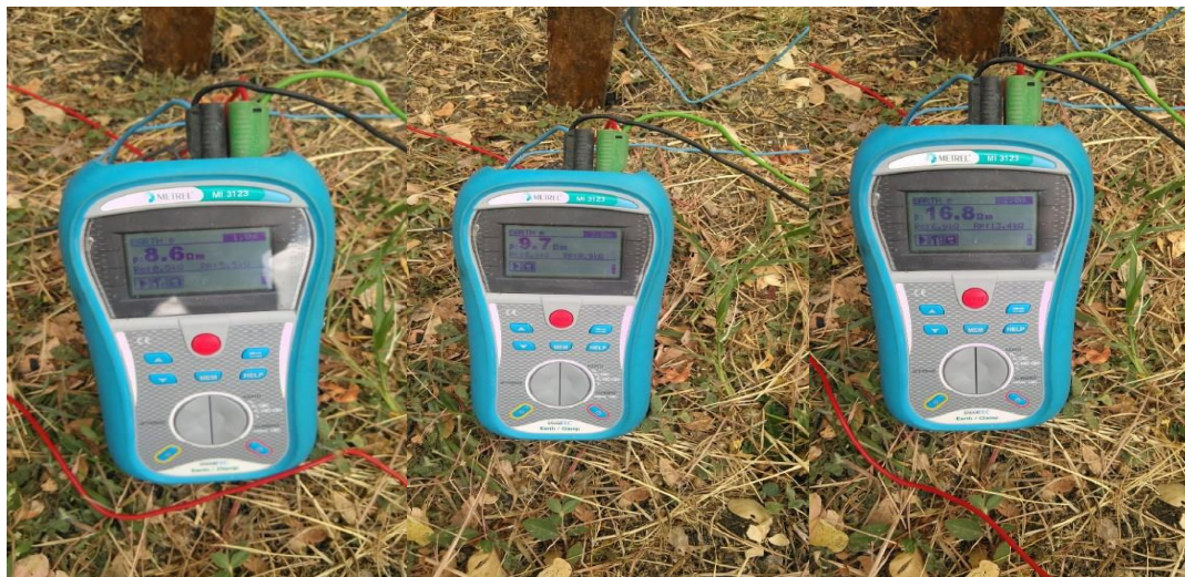
Figura 4-9: Registro fotográfico 3: Telurómetro MI 3123 SmartecEarth/Clamp de la marca METREL
