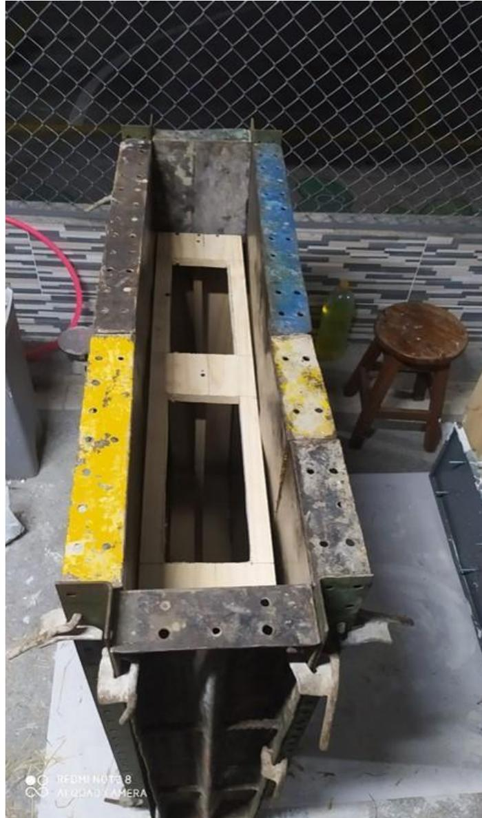
**Figura 28.** Encofrado con formaleta metálica. Fuente: autor
