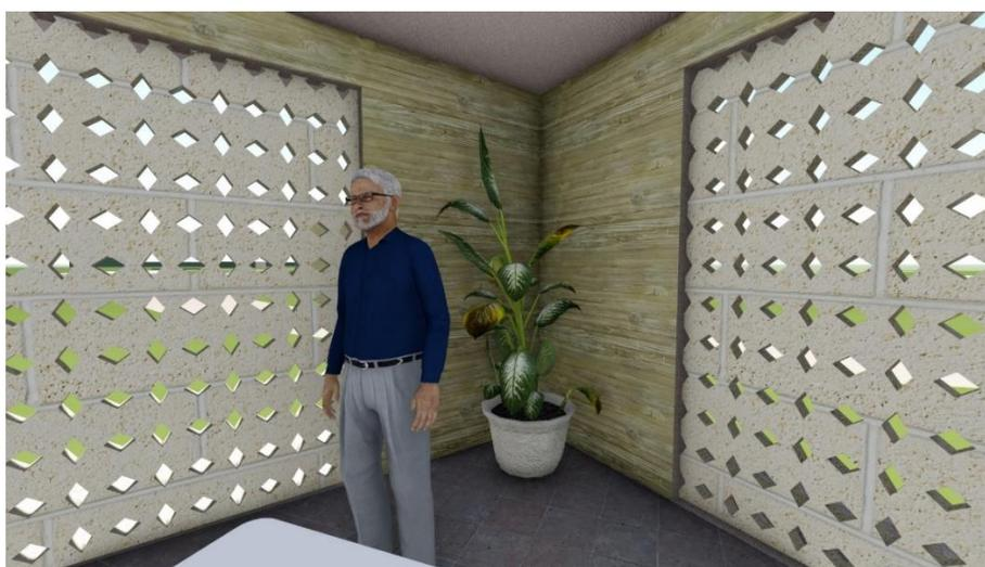
**Figura 36.** Render de ladrillo calado 11 MH usado como muro
