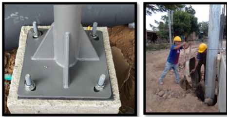
Fig. 25. Base de anclaje de poste
