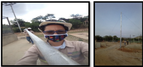
Fig.26. Montajes de postes
