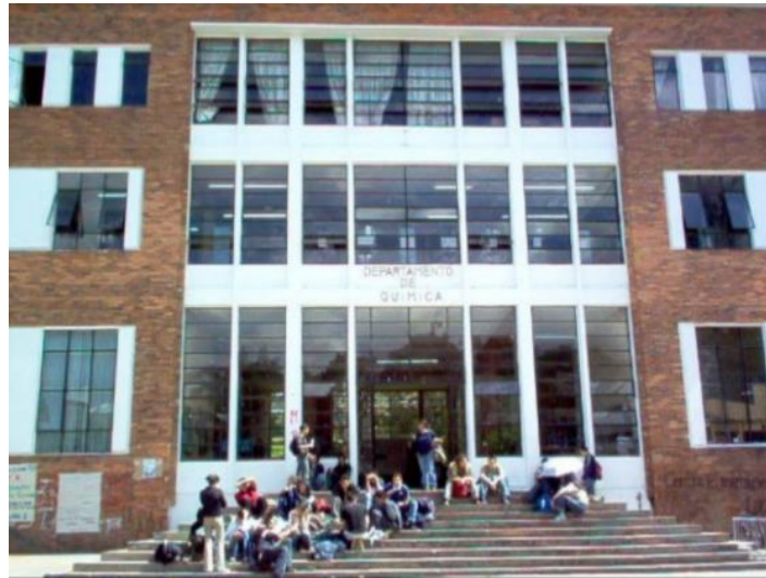
Figura 150. Fachada Facultad de Química. Fuente https://es.slideshare.net/EMAURICIO21/obra-leopoldo-rother
