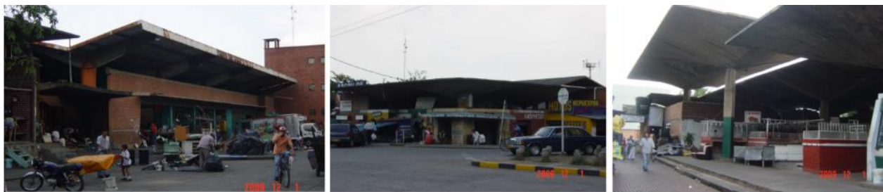
Figura 184. Galería Siloé. Fuente BIC M1-64.
