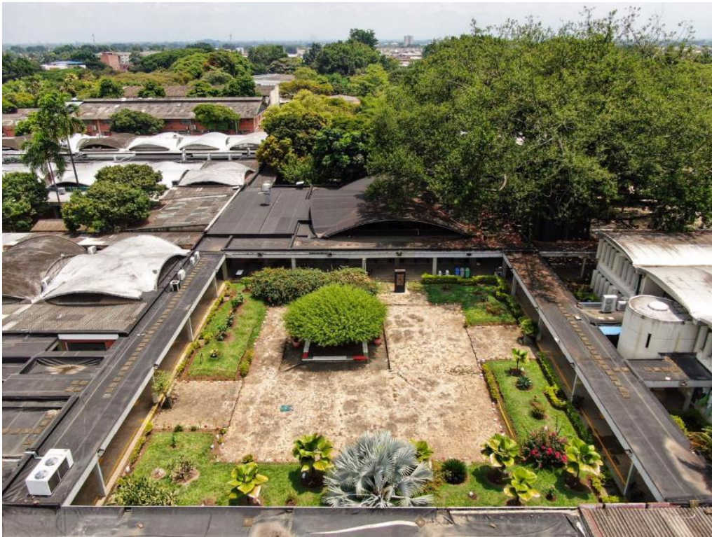
Figura 89. Aerofotografía patio interno. Fuente Arq. Miguel Galeano.
