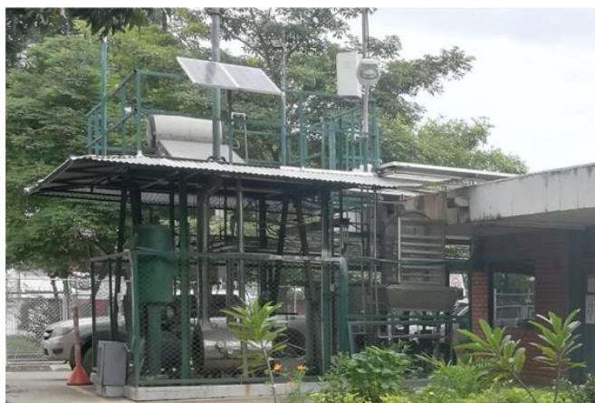
Figura 164. Torre de trabajo seguro en alturas, practicas para instalacion de paneles solares. Fuente propia..
