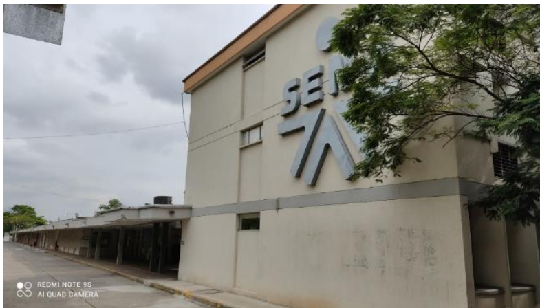
Figura 103. Volumen adosado. Fuente propia.
