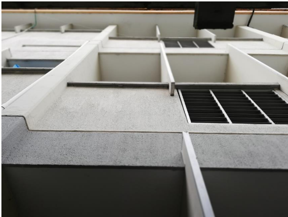
Figura 90. Fachada CEAI. Fuente propia.
