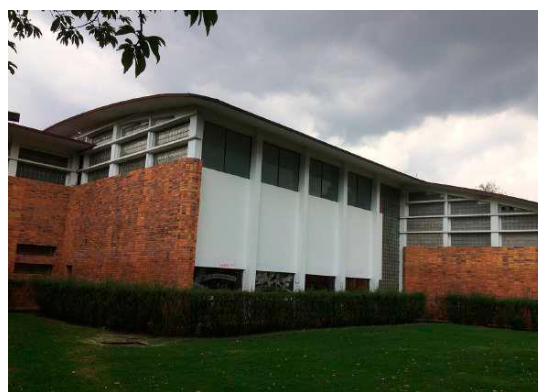
Figura 176. Imprenta UNAL. Fuente Estructuras laminares en Colombia (1945-1970)
