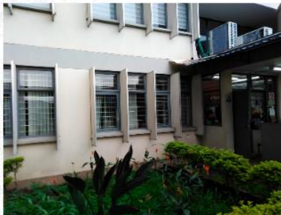
Figura 172. Fotografía de Fachadas.
