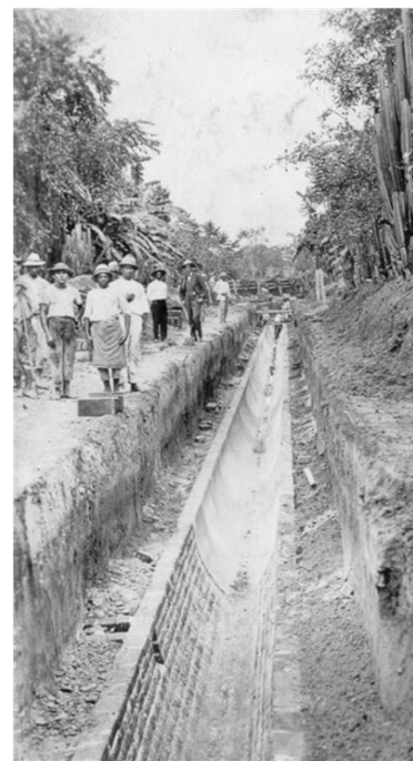
Fuente: Biblioteca municipal, construcción del canal de alcantarillado de Palmira.
