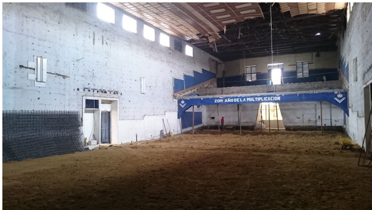
ilustración 67. Nivelación nave central y demolición de palco.
