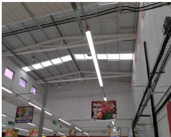
ilustración 69. Cerchar metálicas actuales y teja trapezoidal.
