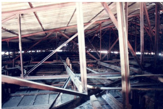
ilustración 139. Estructura de cubierta y teja en eternit original.
