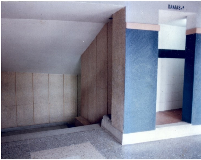
Circulación a baños estado original.
