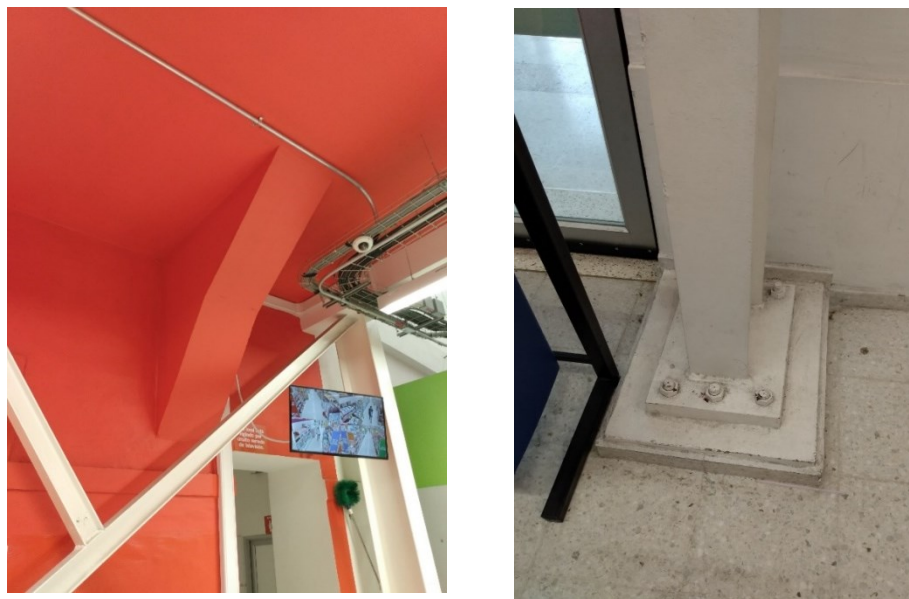
ilustración 70. Reforzamiento estructural en estructura metálica.
