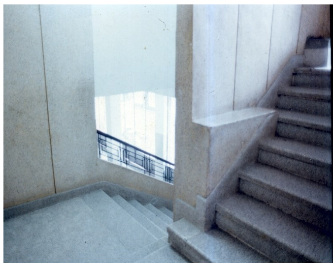
Escaleras estado original.
