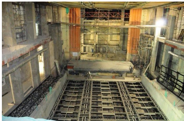
ilustración 101. rehabilitación en proceso del Teatro Materón.
