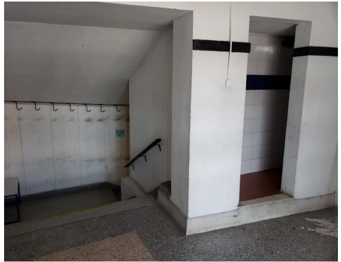
Circulación a baños estado actual.
