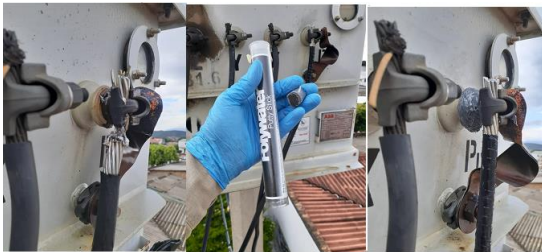
Fig. 4 Proceso de sellamiento a transformadores conectados a la red.
