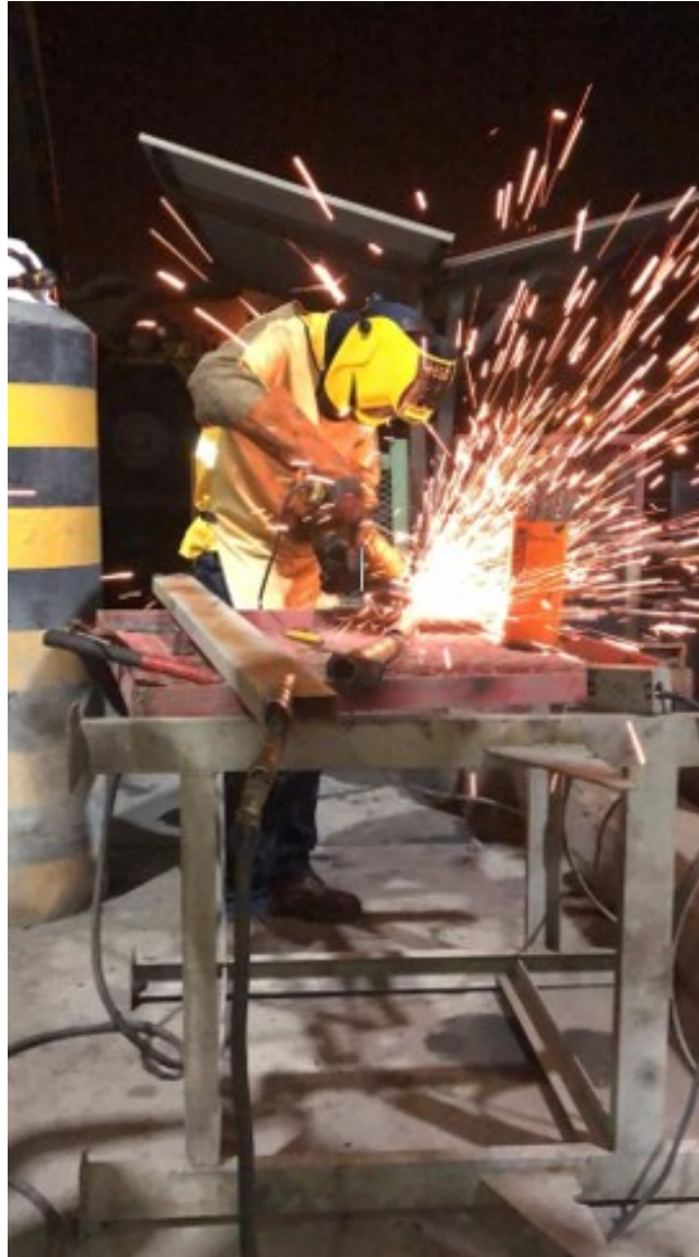
Figura 3-32. Corte de Láminas de Metal.
