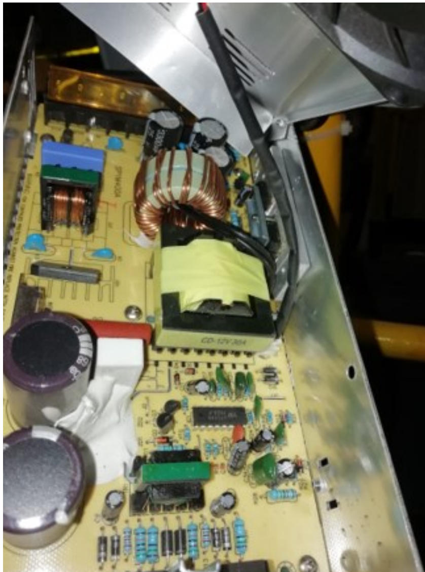
Figura 3-23. Tarjeta Eléctrica del Sistema de Tracción.
