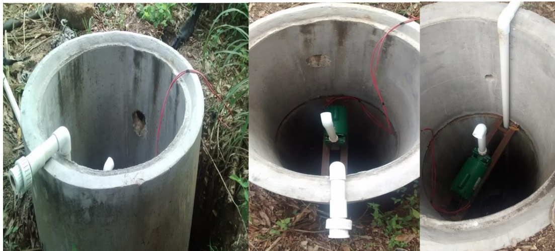
Figura 4- 11: Reservorio actual para suministro de agua en la finca El Manantial
