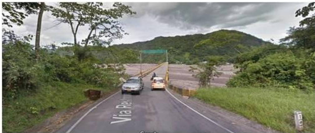
Puente Río Guatiquia
