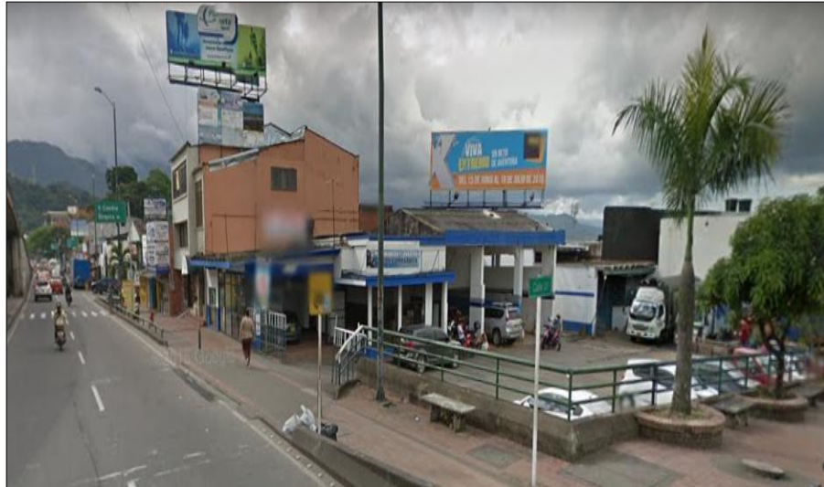
Ilustración 27 Espacio público en deterioro
