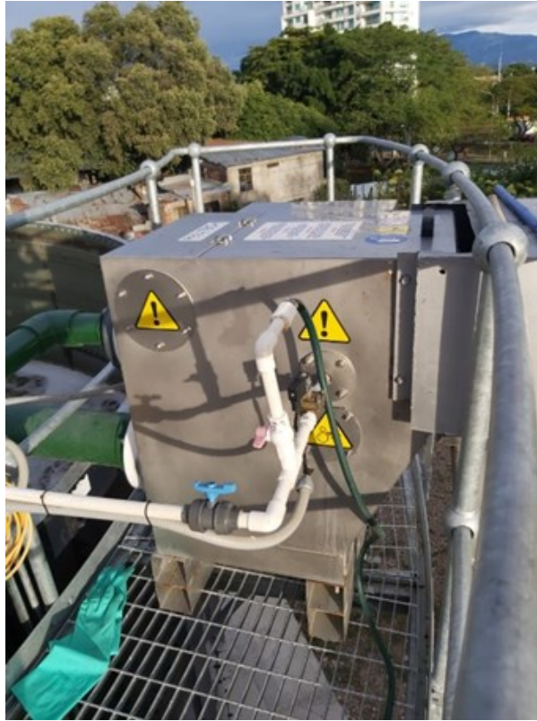
Figura 2-4 Tamiz Rotativo del Sistema de Alimentación
