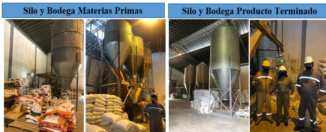
Silos y bodega de MP y PT
