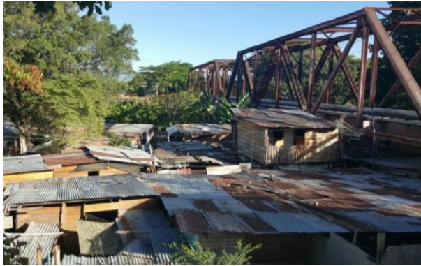
Figura 54, Fotografía asentamiento bajo Tenerife I, Fuente propia.
