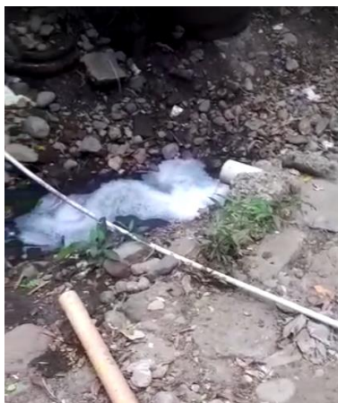
Figura 62, Evidencia de aguas negras atravesando el asentamiento; Fuente propia
