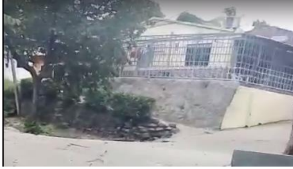
Figura 53, Fotografía viviendas en material, pero en mal estado, Fuente propia.
