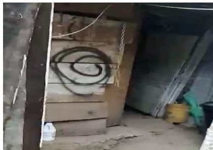
Figura 48, Fotografía estado de vivienda; Fuente propia.
